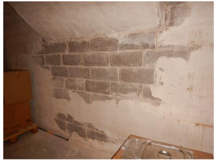
Putssläpp på insida av grundmur.
