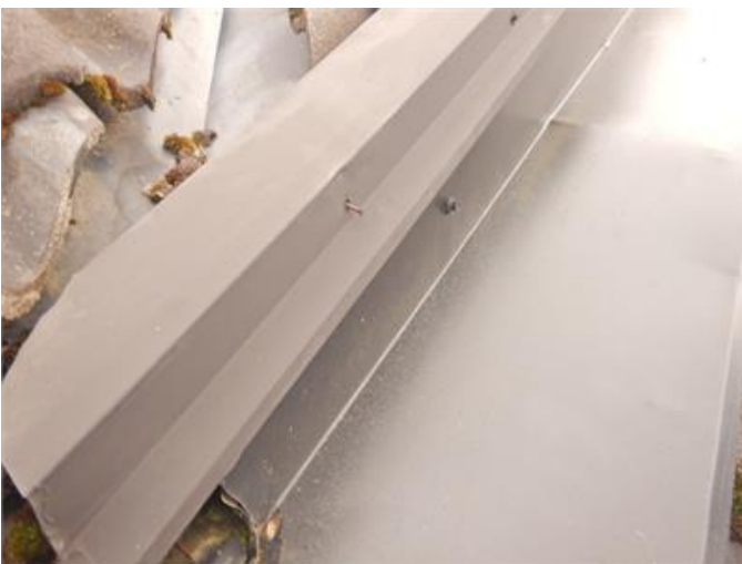
Lösa skruvar vid infästning av vindskiva.
