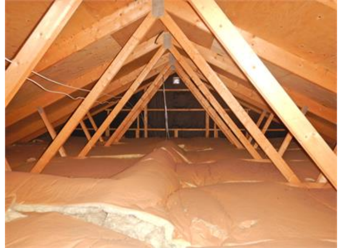
Vind över äldre del
