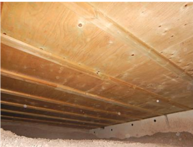
Undersida av bjälklag tillbyggnad.
