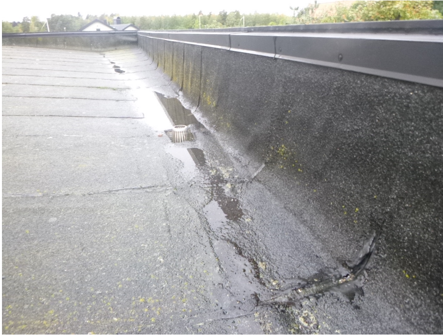
Papptäckning ovan garagebyggnad.
